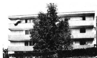
Grossformatige, farbige «Pelichrom»-Platten als Vorhangfassade an einem Mehrfamilienhaus
