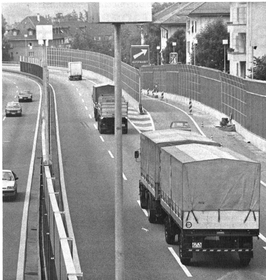
Beispiel für Lärmbekämpfung: Lärmschutzwände an der N6 in Bern
