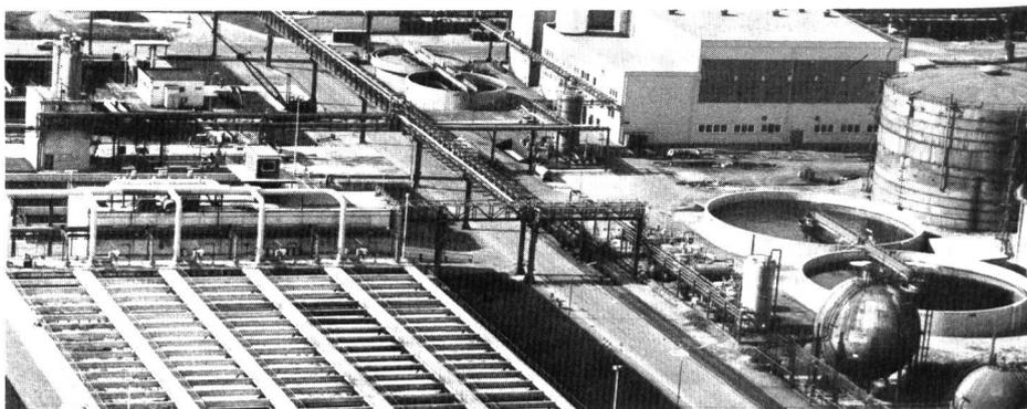
Die zweite Ausbaustufe der Bio-Anlage in Hoechst: abgedeckte Vorklärung, Belebungsbecken mit Maschinenhaus und Druckluftzuführung, Nachklärbecken (teils verdeckt), Neutralisation, Schlammmeindicker (Rundbecken), Filtergebäude zur Schlammmentwässerung.
