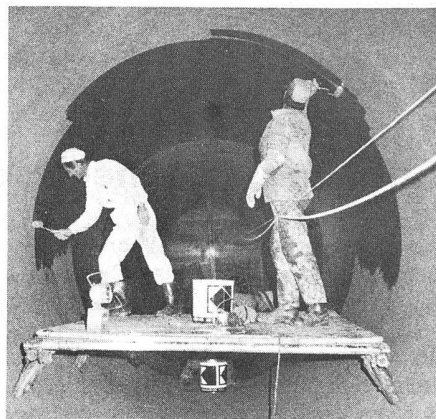
Abb. 1. NOK-Kraftwerke Sarganser-land. Innenbeschichtung im oberen Druckschachtbereich des Druckschachtes Sarelli. Vorbehandlung: SA 3. Beschichtungs Aufbau: 2× Chromidur-F-Zinkstaubfarbe, 2× Chromidur FT.
