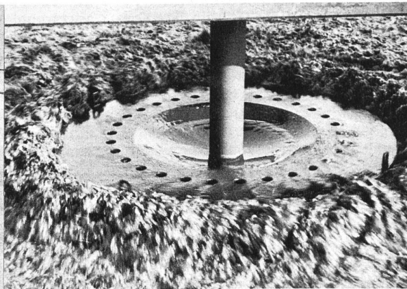
Die Belüftungsbecken sind mit je zwei Oberflächenbelüftern ausgerüstet, welche die Bakterien des Belebtschlammes mit Sauerstoff versehen. Zugleich sorgen sie für die Durchmischung des Beckeninhaltes.
