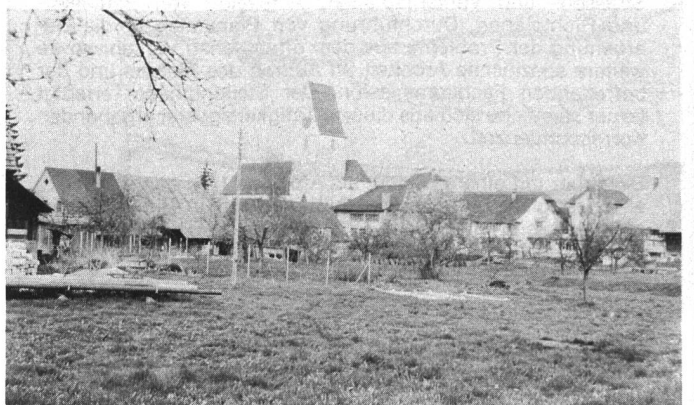
Landwirtschaftlich genutzte Wiese als Baulücke im Zentrum von Hägglingen AG. Das neue Postgebäude (in der Mitte des Bildes mit Giebel) fügt sich dank Übereinstimmung in Volumen, Dachform und Firstrichtung gut in den Dorfkern ein.
