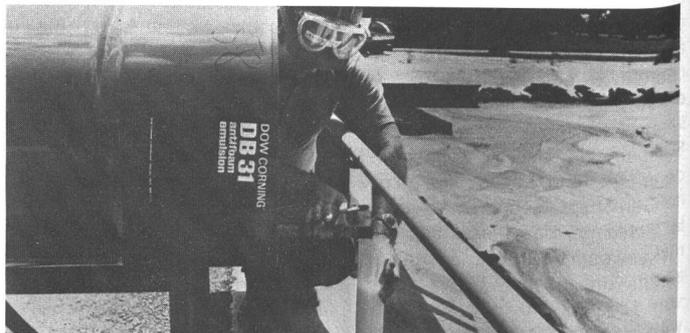
Ein Techniker der BASF-Kläranlage in Louisiana, USA, entnimmt eine kleine Menge des Siliconentschäumers Dow Corning® DB-31 aus einem Behälter seitlich des Durchlüftungsbeckens. Rechts im Bild die Schaumansammlung an der Beckenoberfläche.
