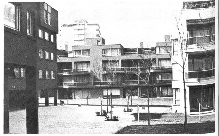
Die durchgehende Laube mit unterschiedlicher Tiefe mildert den Übergang vom öffentlichen Trottoir zum privaten Bereich.
