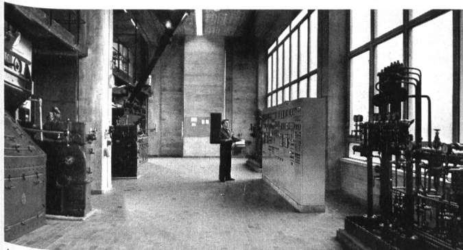
Kohle- und ölgefeuerte Sulzer-Dampferzeuger, Leistung je 40 t/h bei 66 bar und 475°C, Baujahr 1961, im Fernheizkraftwerk der Stadt Bern.
