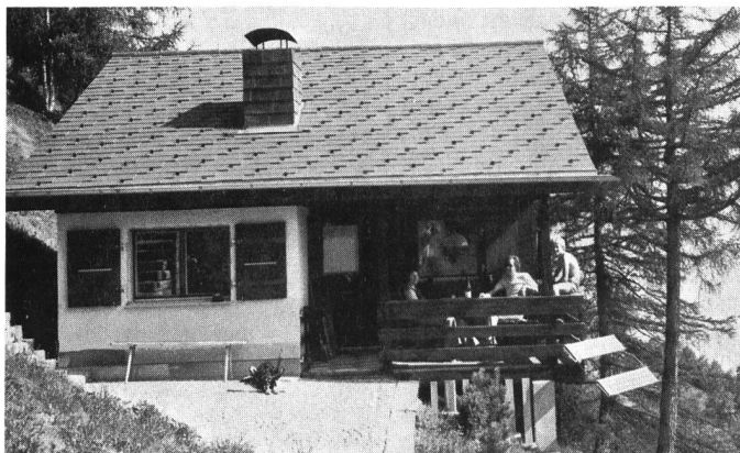
Ferienhaus im Wallis für Wochenend- und Ferienbetrieb: 40 Watt Leistung; 10 Lampenstellen.
