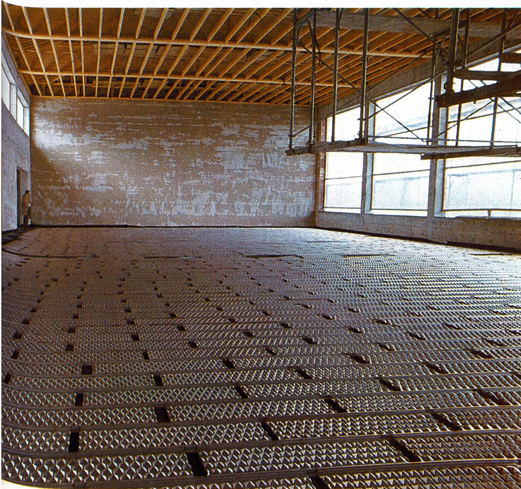
Abb. 1. PYD-System mit Wärmeleitblechen
