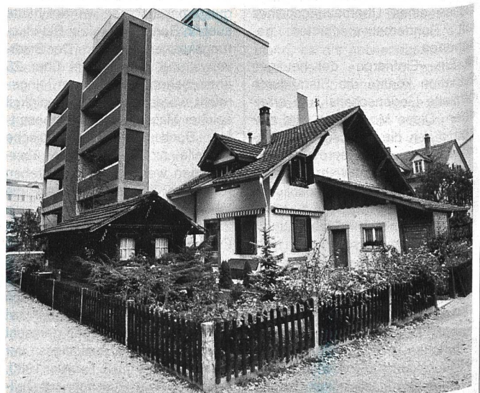
Abbrüche und Neubauten haben zu offensichtlichen Verschlechterungen im Quartier geführt (Bild Wehrin).
