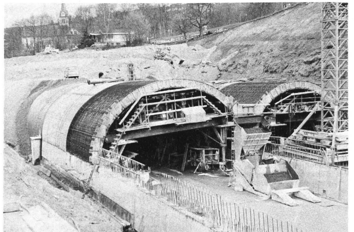
Blick auf die Baustelle des Tunnels Eich der N2 am rechten Ufer des Sempachersees. Aushub, Betonieren und Abdichten erfolgen in einem Taktverfahren. Nach dem Ausheben der Baugrube und dem Deponieren des Aushubs wird die Betonsohle erstellt. Anschliessend werden zuerst die Wände (Seite und Mitte) betoniert, die ihrerseits die stark armierten Betongewölbe aufnehmen. Darüber wird direkt die Sarnafil FP-Dichtungsbahn in einer Stärke von 4 mm verlegt. Die Dichtung schliesst beidseitig an vorher verlegte Drainageleitungen an. Über der Dichtung wird direkt das Aushubmaterial wieder eingeschüttet (Foto: Sarna Kunststoff AG, 6060 Sarnen).
