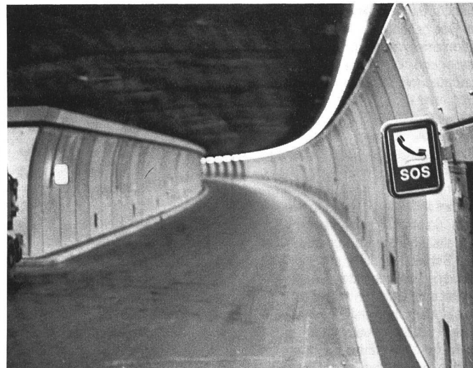
Die 204 Notrufstationen des Gotthard-Strassentunnels sind in Fahrtrichtung Nord-Süd in Nischen, in Richtung Süd-Nord in Schutzräumen untergebracht. Der Abstand zwischen den Nischen beträgt 125, jener zwischen den einzelnen Schutzräumen 250 m.
