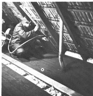
Nachträgliche Dämmung der Dachschrägen von der Kehlbaldendecke aus.
