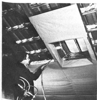
Bei Neubauten wird Thermoschaum hinter Unterspannbahnen gespritzt.
