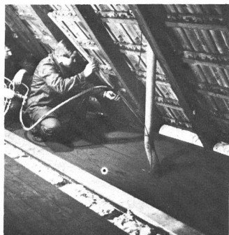
Nachträgliche Dämmung der Dachschrägen von der Kehlbaldendecke aus.
