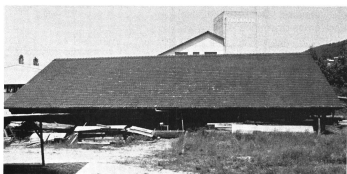
Abb. 12. Einzelfläche Ziegelgedach Gümligen.
