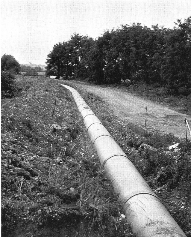
Druckleitung \varnothing 1000 mm, PN 4
