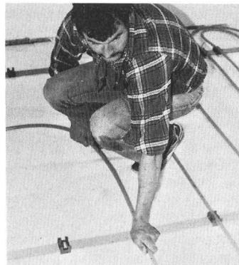
Die Unitex-Fussbodenheizung wird im Schnellsteckverfahren verlegt.
