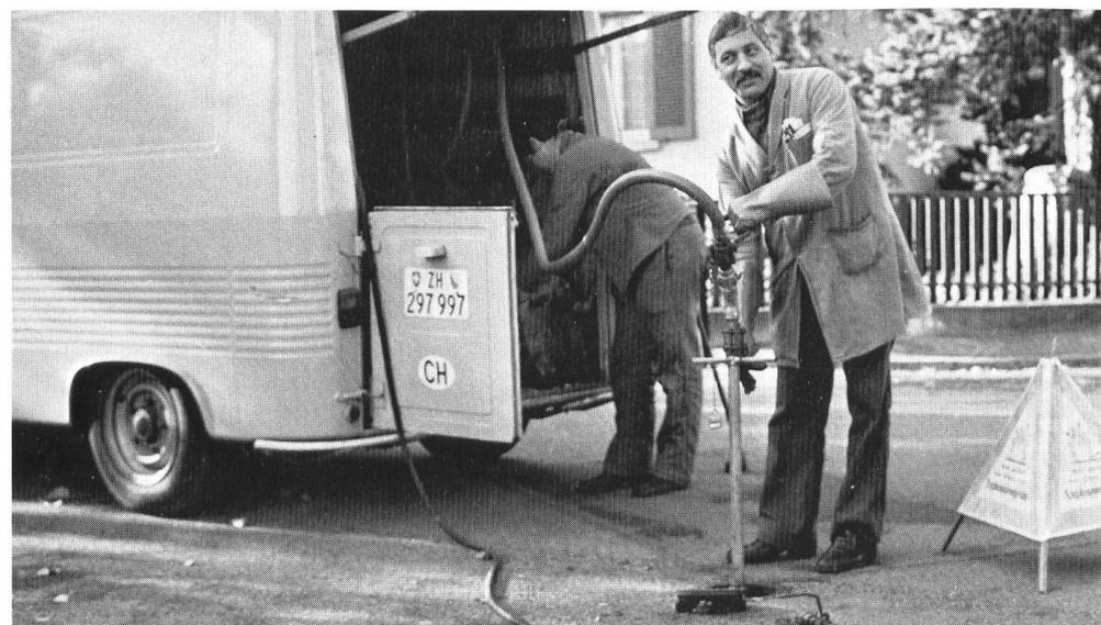
Regenerierung alter Gussleitungen nach dem Fliessverfahren, hier beim Einfüllen in eine Leitung.
