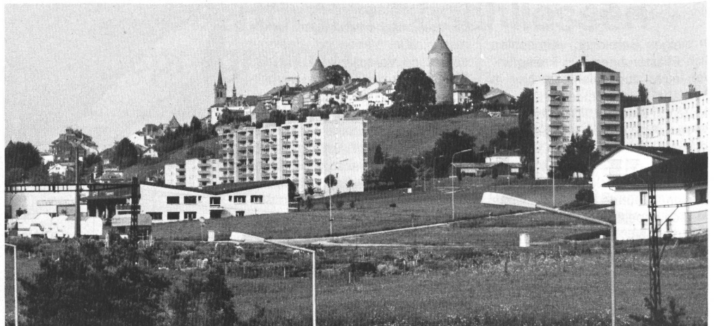
Und so zeigt es sich heute. Die Erhaltung von Ortsbildern scheitert nicht am Schutz von Fassaden und Baudenkmälern, sondern am Bauchaos in ungeschützter Umgebung.
