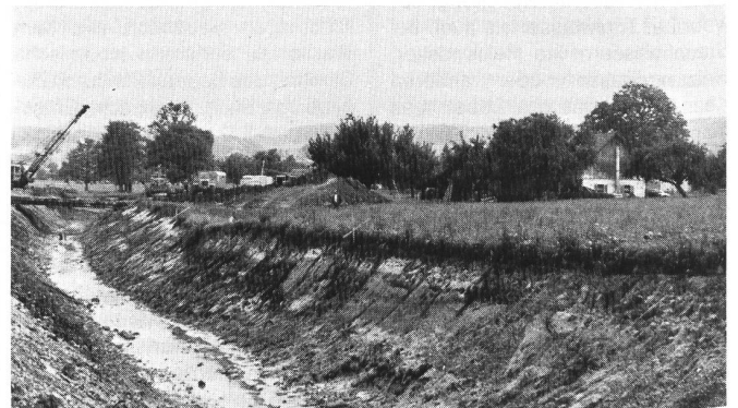
Abb. 1. Der mit Bagger ausgehobene Kanal, bereit für das Einlegen der Kunststoff-Dichtungsbahnen. Man beachte den sehr heterogenen Boden, in Bildmitte unten Bäume und Äste aus längst vergangenen Zeiten.
