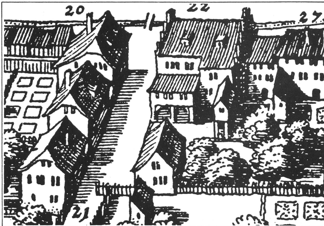
Historische Reihenhäuser, vorgelagerte Nutzgärten, Verdichtung mittels An- und Zwischenbauten in Zurzach.
