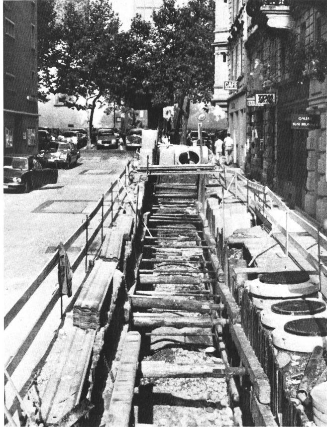
Spitalgasse. Installationsplatz hinter der Absperrung und über dem Graben.
