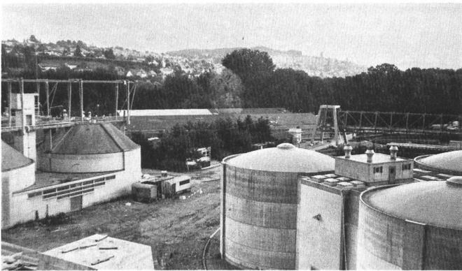
Links die Behälter der bestehenden Faulanlage, rechts davon die Behälter der Voreindickanlage. In der Bildmitte das Dach der neuen Fahrzeugeinstellhalle und ein Teil der Stahlkonstruktion des rund 1 km langen Energiekanals, der über die gesamte Anlage führt.
