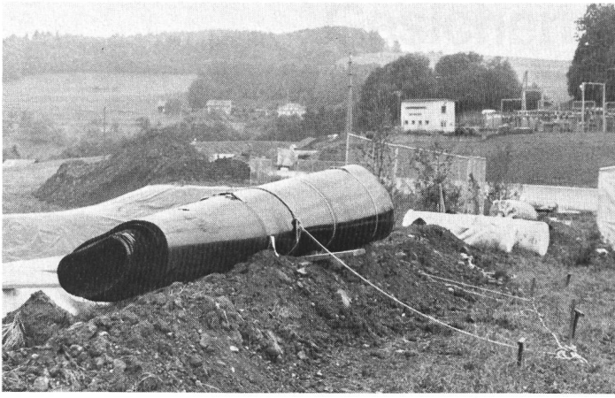
Abb. 6. Sarnafil-P-Rolle bereit für das Ablassen über den Böschungrand.
