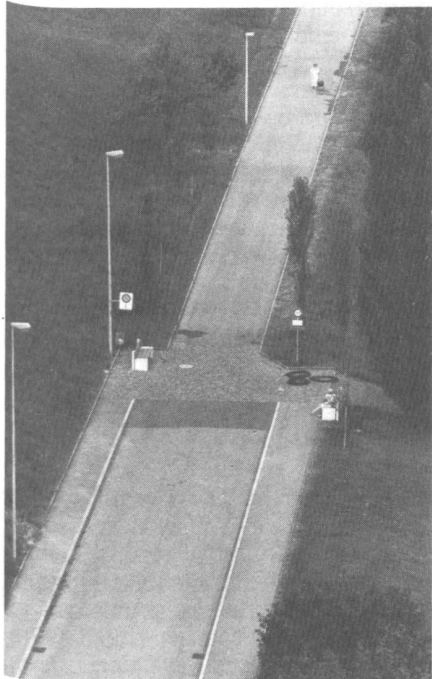
Umdenken im Strassenbau am Beispiel Zurzach: Blick vom Turmrestaurant auf die Quellenstrasse. Eine Aufpflasterung bildet den Übergang vom «Normalquerschnitt» zur «bescheidenen» Fortsetzung.
