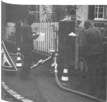
Kurzzeitige Hydrantenentnahme.
