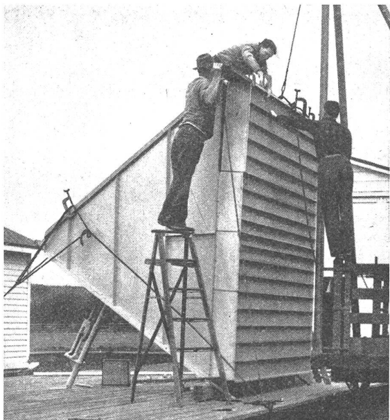
Bild 7: Aufstellung des ersten großen Modells einer Radio-linsenantenne.
