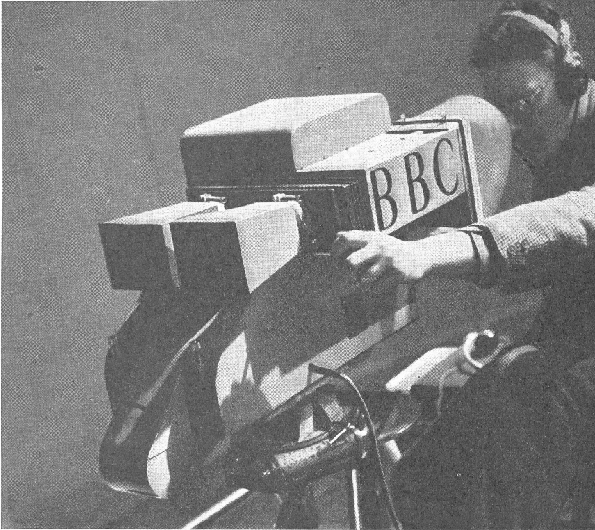
Bild 3: Die nach dem Prinzip des Ikonoskops konstruierte Emitron-Kamera der BBC. Die Kamera arbeitet vollkommen lautlos, damit störende Geräusche während der Sendung vermieden werden. Auf einem Gestell mit pneumatikbereiften Rädern läßt sie sich durch das Studio fahren, um während der Sendung den Ort zu wechseln. Die Bedienmannschaft ist durch Kopfhörer mit dem Kontrollraum in ständiger Verbindung, von wo sie ihre Weisungen erhält.
