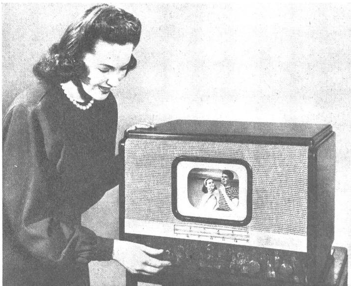
Bild 24: Kleines amerikanisches Tischmodell mit einer Fernschröhre von 17½ cm Durchmesser. Die Bilder sind so hell, daß sie in normal beleuchteten Räumen betrachtet werden können.
