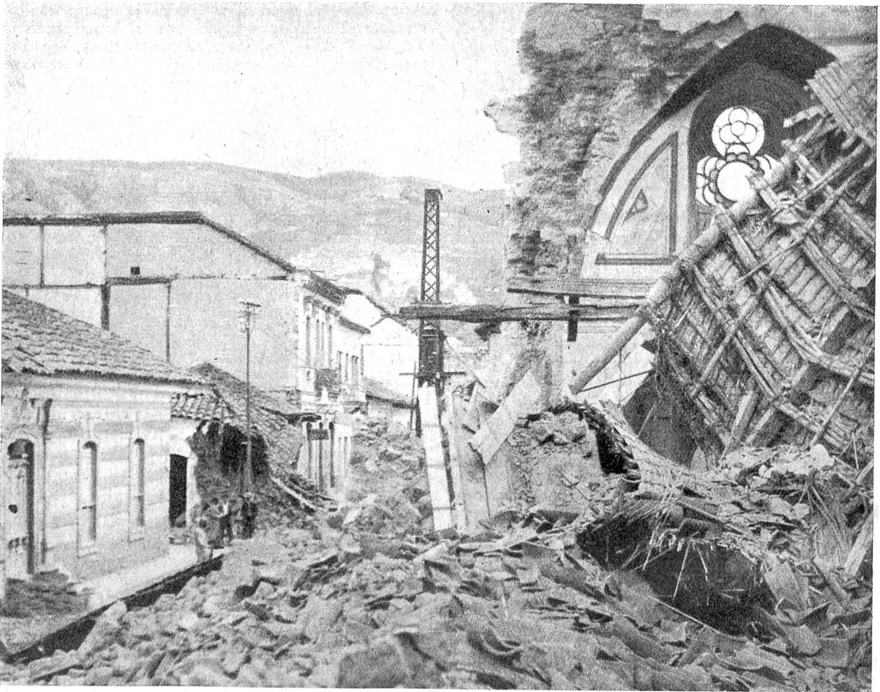
Ruine der Kathedrale von Ambato in Ecuador nach einem Erdbeben
