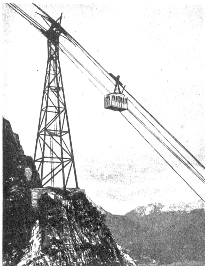
Abb. 2. Beispiel einer der früher gebauten Großseilbahnen. Die Zugspitzbahn bei Stütze 2
