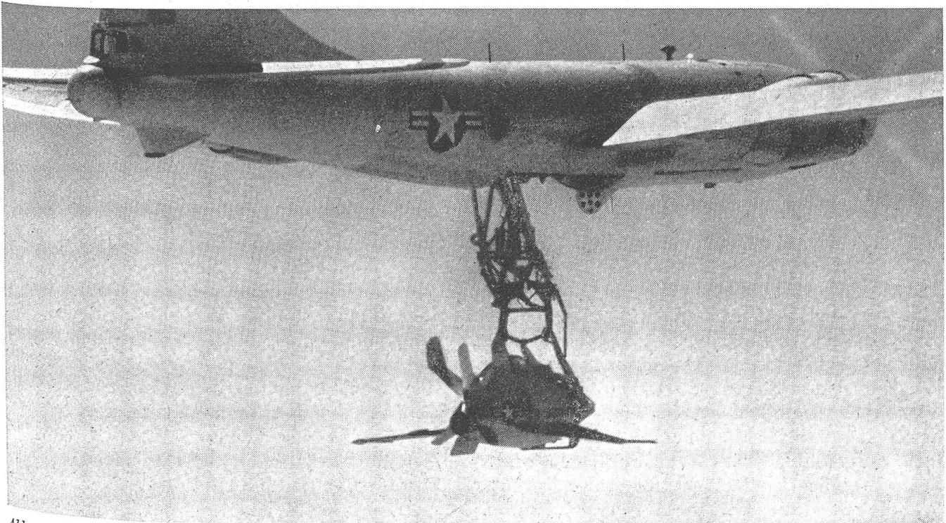
Abb. 1. Die Superfestung Boeing B-29 hat das „Trapez“ mit dem daranhängenden Parasiten-Flugzeug ausgefahren. Die Flügel des kleinen Jägers sind aufgeklappt. Der Pilot braucht nur noch das Zeichen zum Ausklinken zu geben, um selbständig weiterfliegen zu können. Der Antrieb des Parasiten erfolgt durch ein Düsenaggregat; über seine Schnelligkeit und Steigfähigkeit ist vorläufig noch nichts bekanntgeworden.
