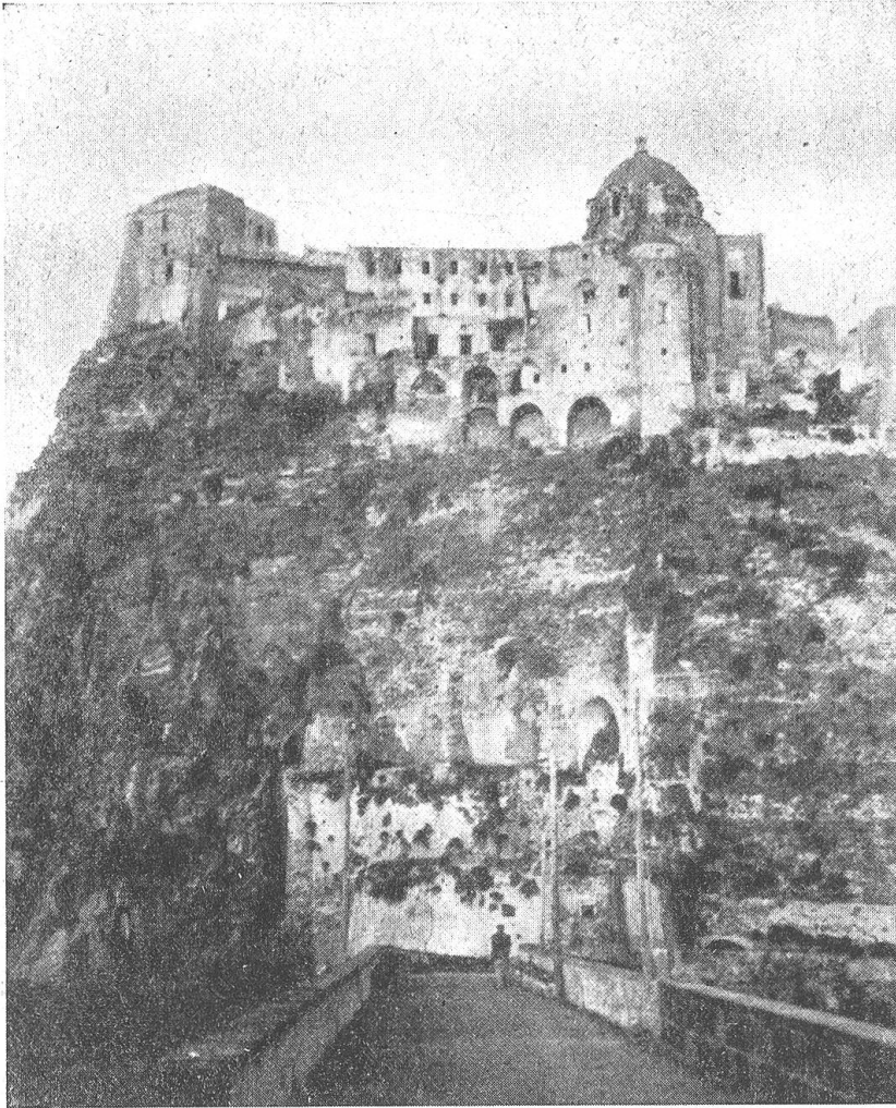
Kühn und weitläufig, fast einem Titanenbau, einer unwirklichen Kulisse ähnlich, bietet sich heute die weitläufige Ruine des Castelllos dem Beschauer dar
