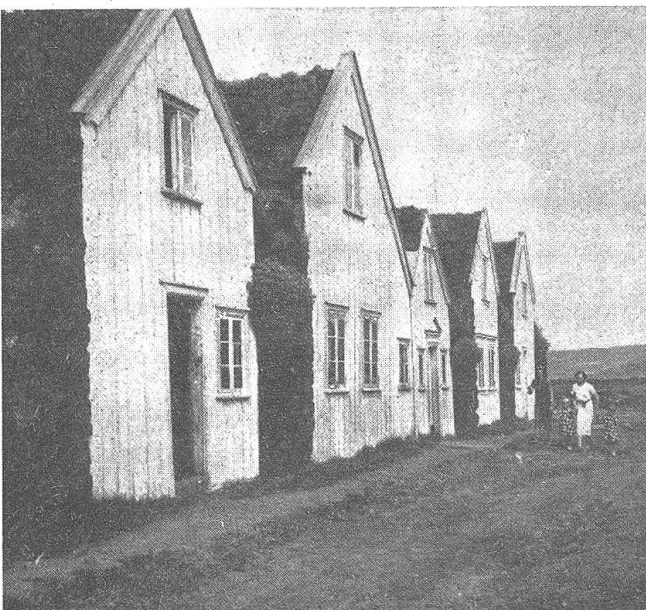
Bei den alten isländischen Bauernhöfen trug jeder Raum für sich ein Dach, das mit Grasziegeln belegt wurde und so den isländischen Stürmen standhalten konnte
