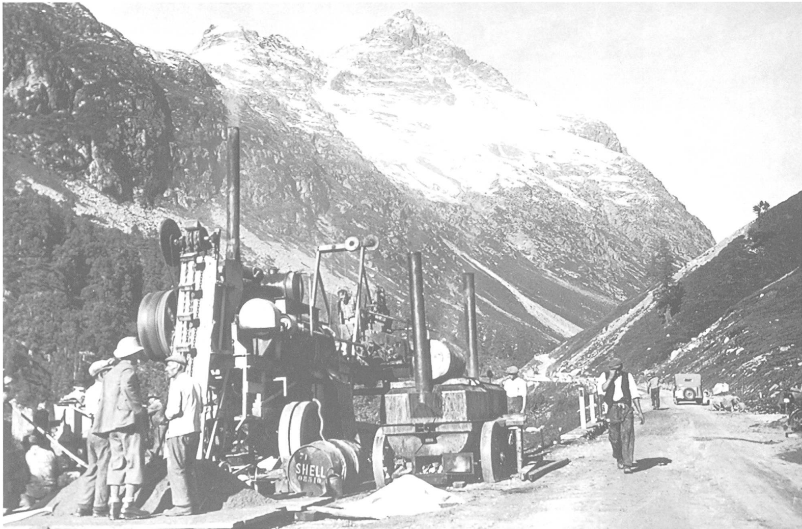
Abb. 7: Strassenausbau auf dem Julier
