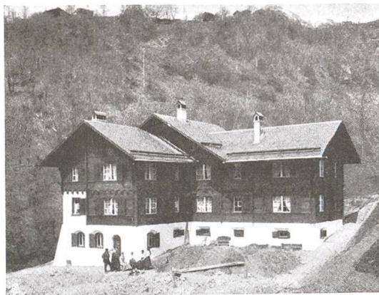
Abb. 11. Maschinenwohnhaus des Elektrizitätswerkes der Stadt Chur. In walddreicher Gegend ein solid fundiertes Holzhaus. Architekt B. S. A. Wühl, Chur. Aufnahme von A. Reinhard, Chur – Fig. 11. Habitation destinée aux machinistes des usines électriques de la ville de Coïre. Maison en bois élevée sur de solides fondements en pierre, en harmonie avec les belles forêts des environs
