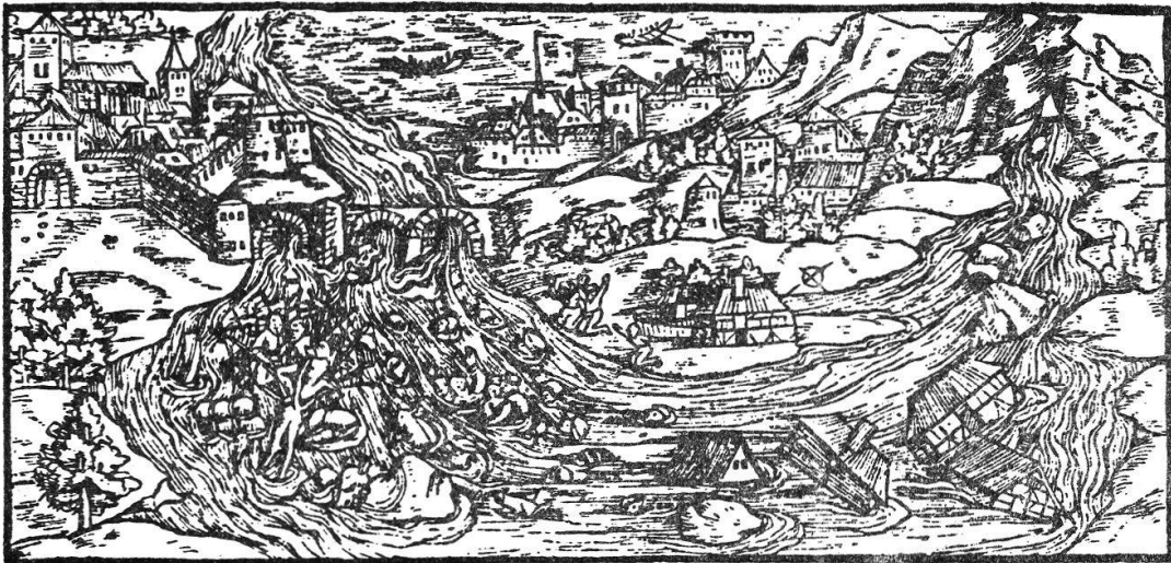
Le acque della Buzza di Biasca travolgono il Ponte della Torretta a Bellinzona
