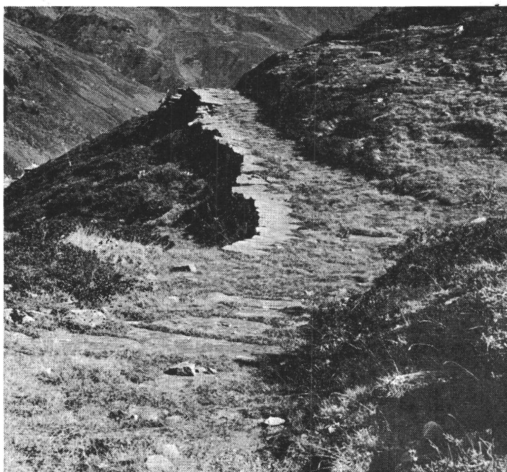
Fig. 19 LA STRADA ALPINA medioevale presso Tällialp, vista da sud. Al centro della foto si vedono le lastre spostate lateralmente in modo da poter collocare in inverno i pali segnastrada. Piano: K.
