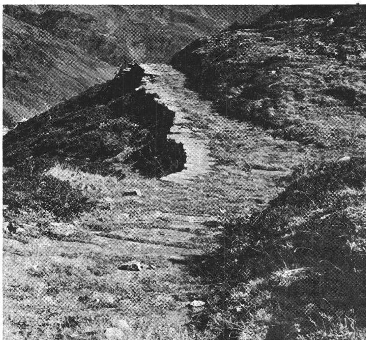
Fig. 19 LA STRADA ALPINA medioevale presso Tällialp, vista da sud. Al centro della foto si vedono le lastre spostate lateralmente in modo da poter collocare in inverno i pali segnastrada. Piano: K.
