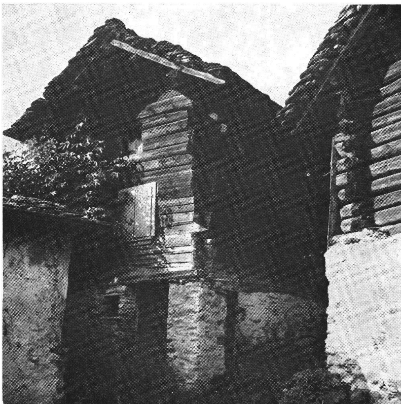
Una delle vecchie case demolite
