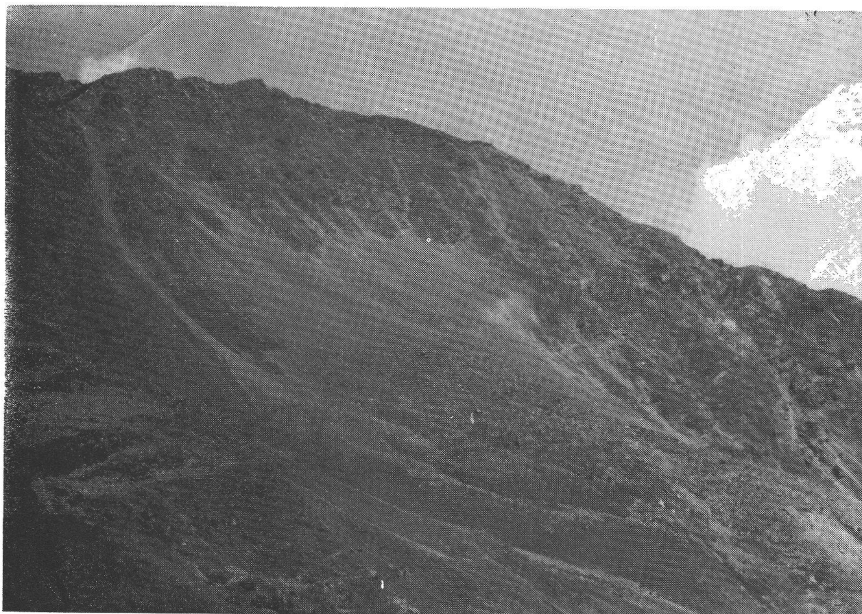
La fronte di distacco della frana di Zarera lungo la cresta della Cima di Cardan, vista dal valico del Bernina
