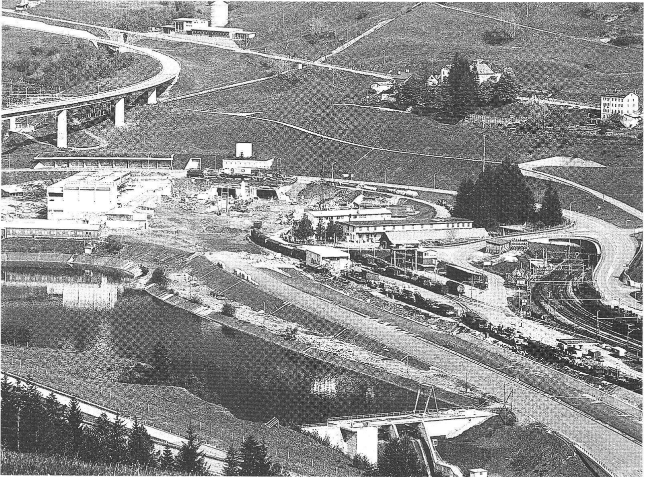
Airolo, Valle Leventina, il Cantiere Sud della galleria stradale del Gottardo
