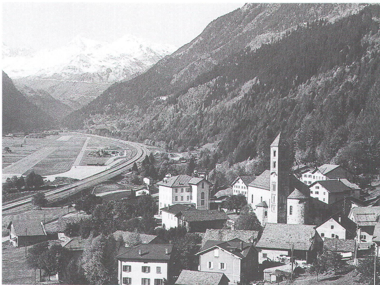
Sull'autostrada del Gottardo
