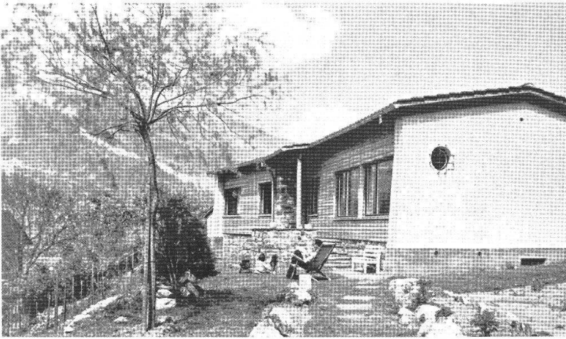
Casa d'abitazione dott. Stampa-Lyss a Coira (1941-42): facciata sud. «Werk», 6 (1946), p. 201.
