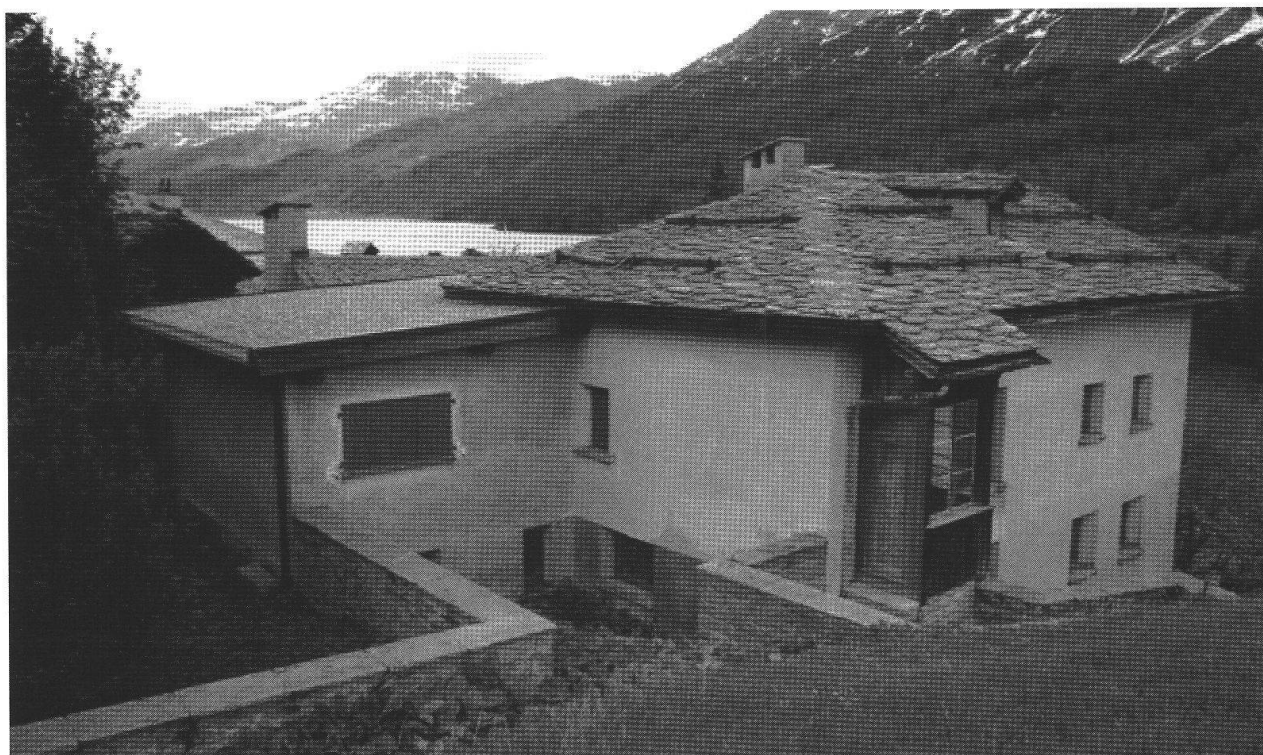
Fabbricato di raccordo con tetto piano tra la casa d'abitazione e la stalla a Maloja/Maloggia-Capolago (1930). Foto: Roland Frischknecht.
