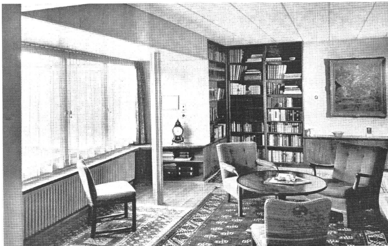
Casa d'abitazione con studio medico a Uster (1945): soggiorno con scaffale a muro come "strato capiente" e, ben visibile al centro, un pilastro di legno con sezione a croce. «Werk», 4 (1948), p. 107.
