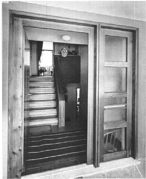
Quartiere dell'EWZ a Vicosoprano: ingresso con vano scale, 20.2.1959. Archivio EWZ.
