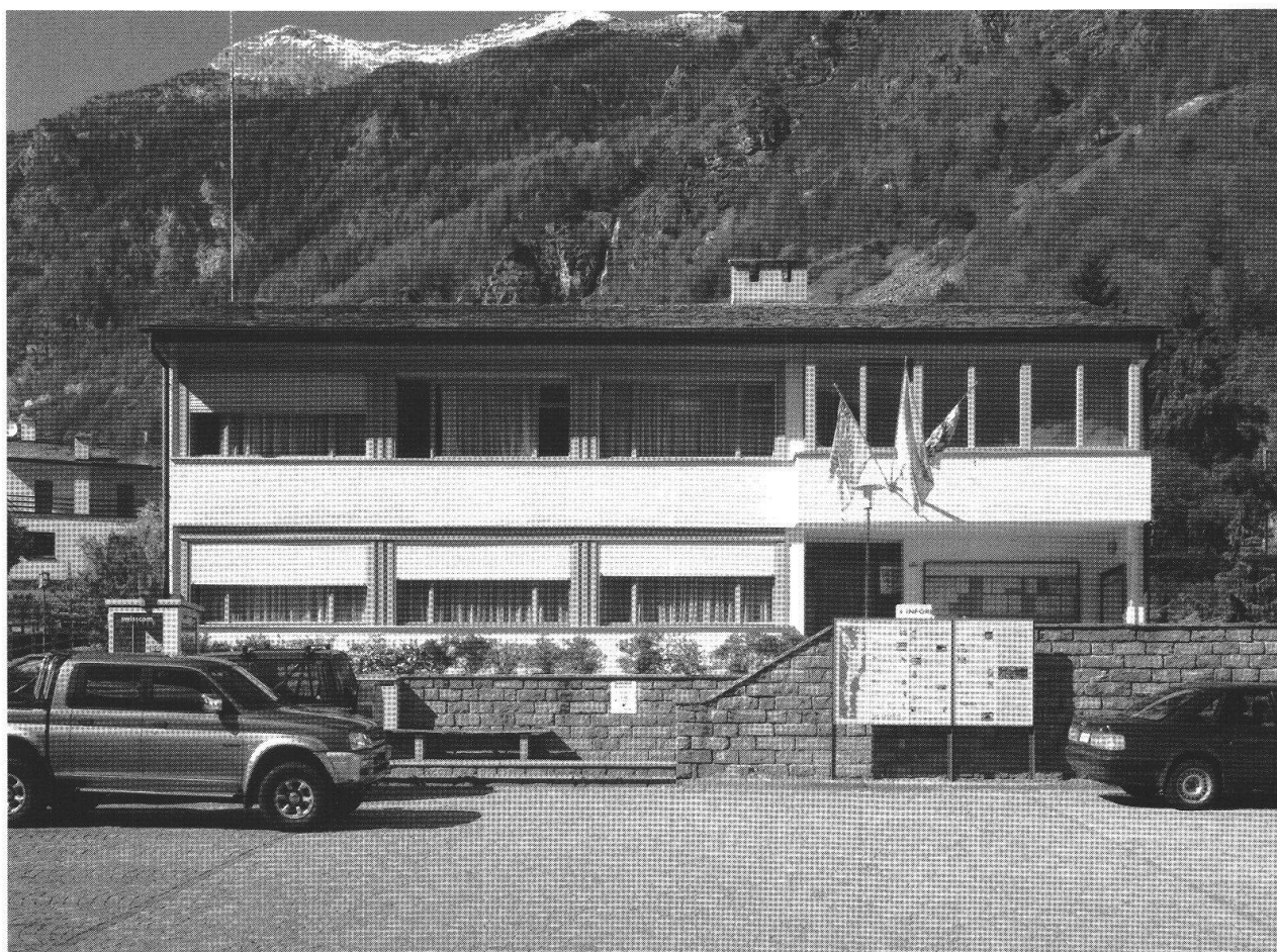
Municipio di Brusio, 1959-62, lato frontale: la sporgenza a erker della sala per il consiglio comunale, rivolta verso la strada, fa da contrappunto agli aggetti del lato nord per gli armadi dell'archivio. Foto: Ralph Feiner.
