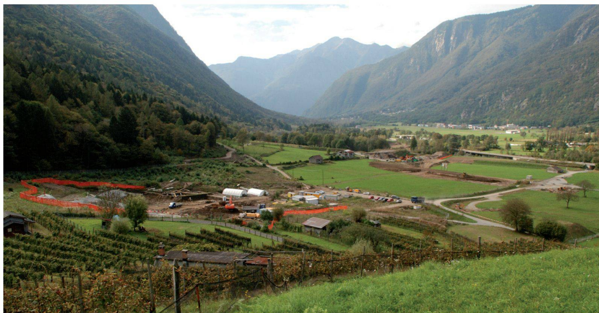
2. Veduta del cantiere da est (foto ADG)
