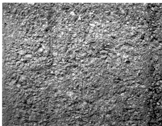
Miller & Maranta. Roccolo. Particolare della facciata
