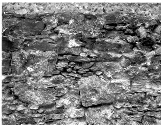
Muro posteriore (particolare)
