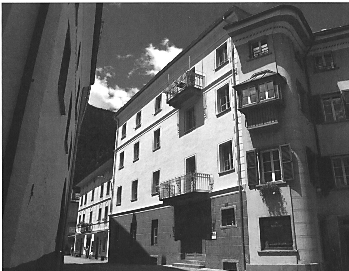
Casa Battaglia, ubicata in via San Giovanni e oggi riammodernata, prima sede del laboratorio della Tessitura
