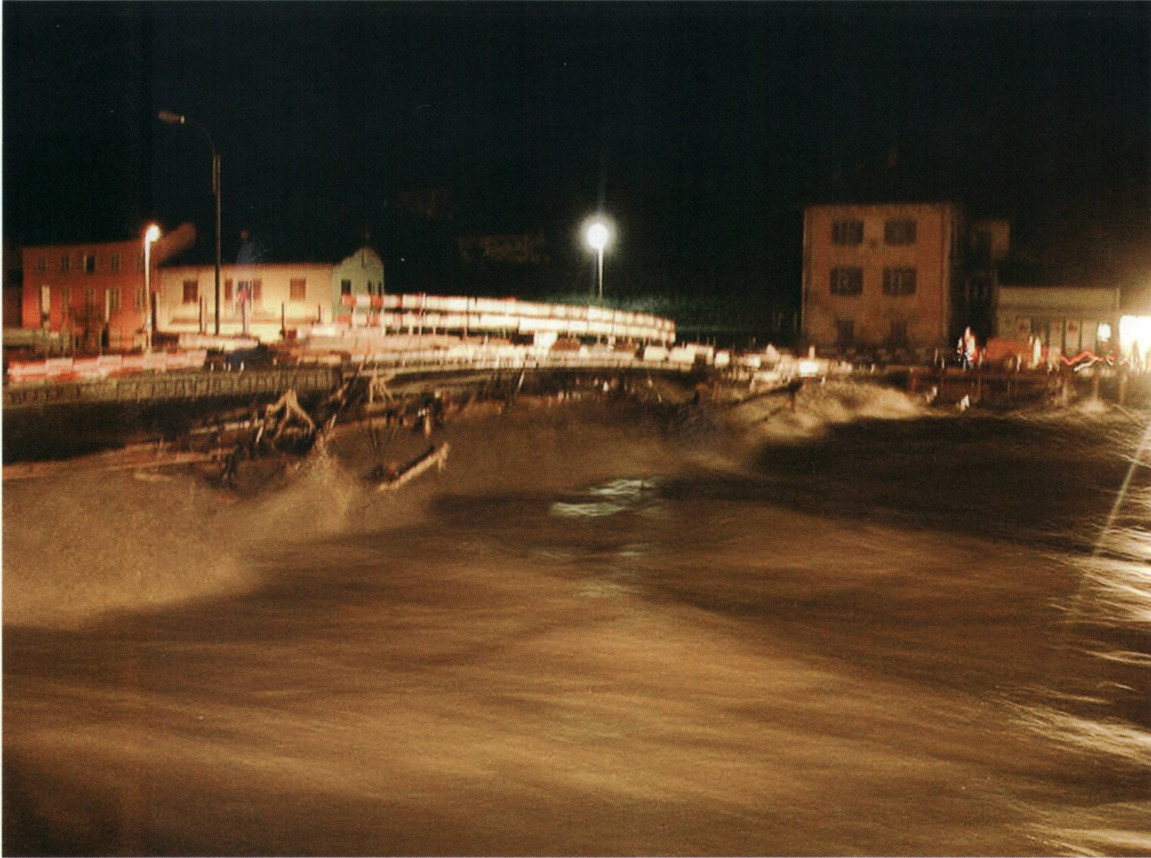
La Moesa in piena lambisce il nuovo ponte in costruzione nell'estate 2006. Fonte: Archivio «Asociacion culturala Rorè – San Vitor»
