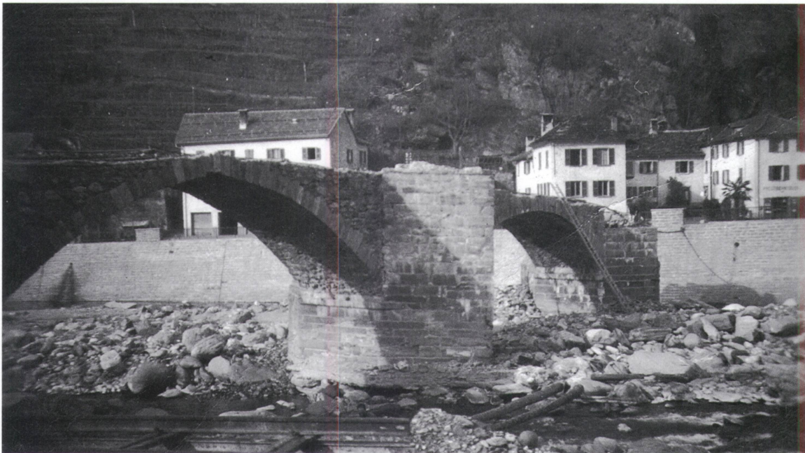
Dopo l'alluvione, in attesa di essere abbattuto, il ponte viene sprovvisto dei parapetti in lastre di granito, che si trovano oggi ancora in certi giardini privati del paese. Fonte: Archivio «Asociazion culturala Rorè – San Vitor» (fondo N. Nicola)
